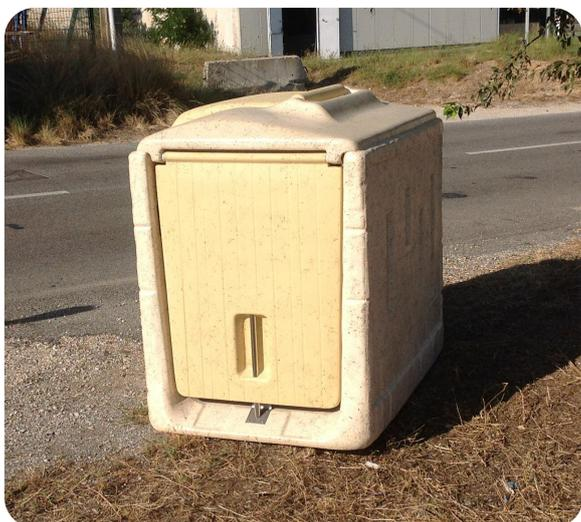
L'espace d'air entre le bac et l'enveloppe béton permet de lutter contre l'effet **cocotte-minute** au soleil, réduit les **odeurs** de condensation, les dispersions des déchets (Vent animaux) et les **nuisances sonores**.
